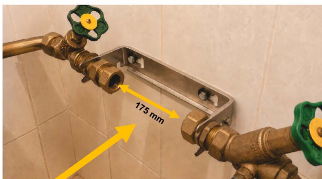
Einbau des neuen REDAC Funk Tauschzählers für Kaltwasser Typ MT-SMARTMESS-JS-SINGLE-JET-REDAC-RADIO-AT-175-CW in den bestehenden alten österreichischen 175 mm Wasserzähler-Einbaubügel
