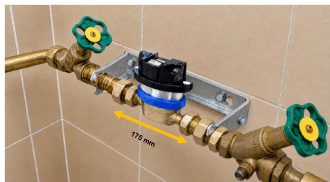
In den alten bestehenden österreichischen 175 mm Gemeindewasserzähler-Bügel neu eingebauter Kaltwasser-Tauschzähler vom Typ MT-SMARTMESS-JS-SINGLE-JET-REDAC-RADIO-AT-175-CW mit einer Einbaulänge von 175 mm. Dieser Zähler kann über das MT-REDAC Funksystem fernablesen werden
